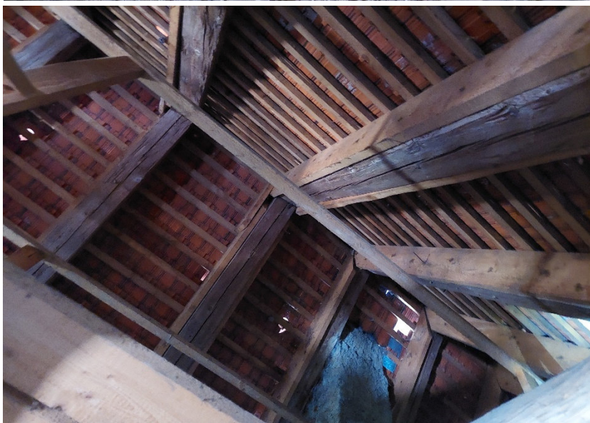
Abb. 11: Dachspitz des Dachstuhls im Schlossgut.
