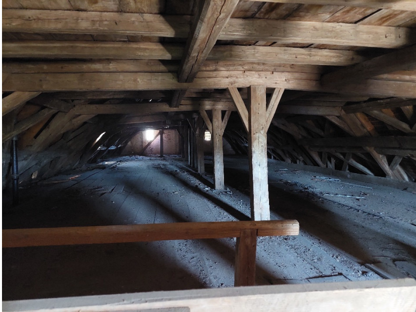
Abb. 9: Unterste Etage des Dachstuhls im Schlossgut.
