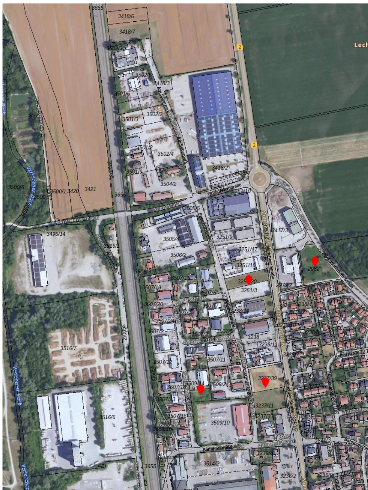
Abb. 8: Flächenanalyse Gewerbe (Baulücken, Flächenreserven als rot markierter Standort), Datengrundlage Bayerische Vermessungsverwaltung 2026, bearbeitet April 2026 (Teil 1)
